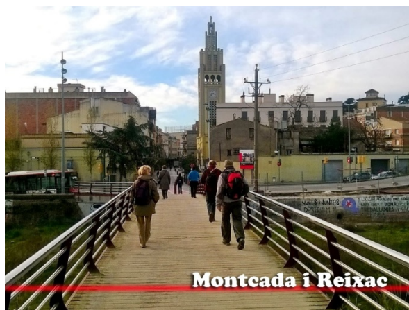
Puente sobre el Ripoll, a la entrada de Montcada
